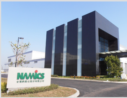
▲台灣納美仕公司銅鑼園區新廠外貌
